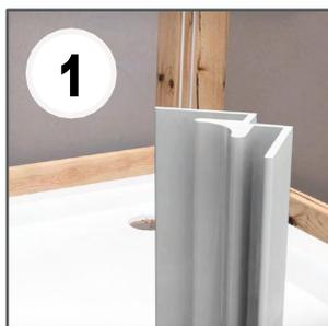
Le premier profilé, soit un coin intérieur de Type A ou un embout de Type C, doit être fixé au mur ou au sol aux extrémités avec des vis à tête fraisée, ou de la colle et un cordon de mastic silicone appliqué dans le creux du profilé.
