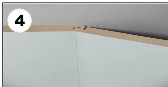
Inclinez la languette du panneau suivant à environ 45°, dans la rainure du panneau déjà fixé. Assurez-vous que la languette soit complètement insérée dans la rainure avant de la clipser au mur, afin de ne pas endommager le joint.
